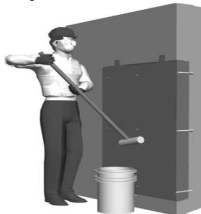
*Imagen 82. Muestra del compuesto curador luego de terminada la reparación y el vaciado.*
