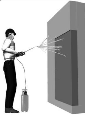
*Imagen 78. Riego para curado de la superficie reparada.*
