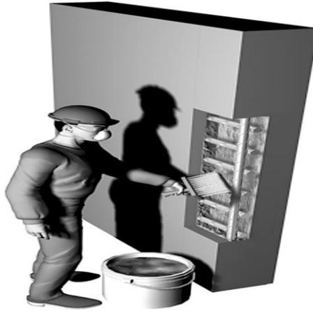
*Imagen 76. Reparación del sustrato y aplicación de inhibidor de corrosión.*
