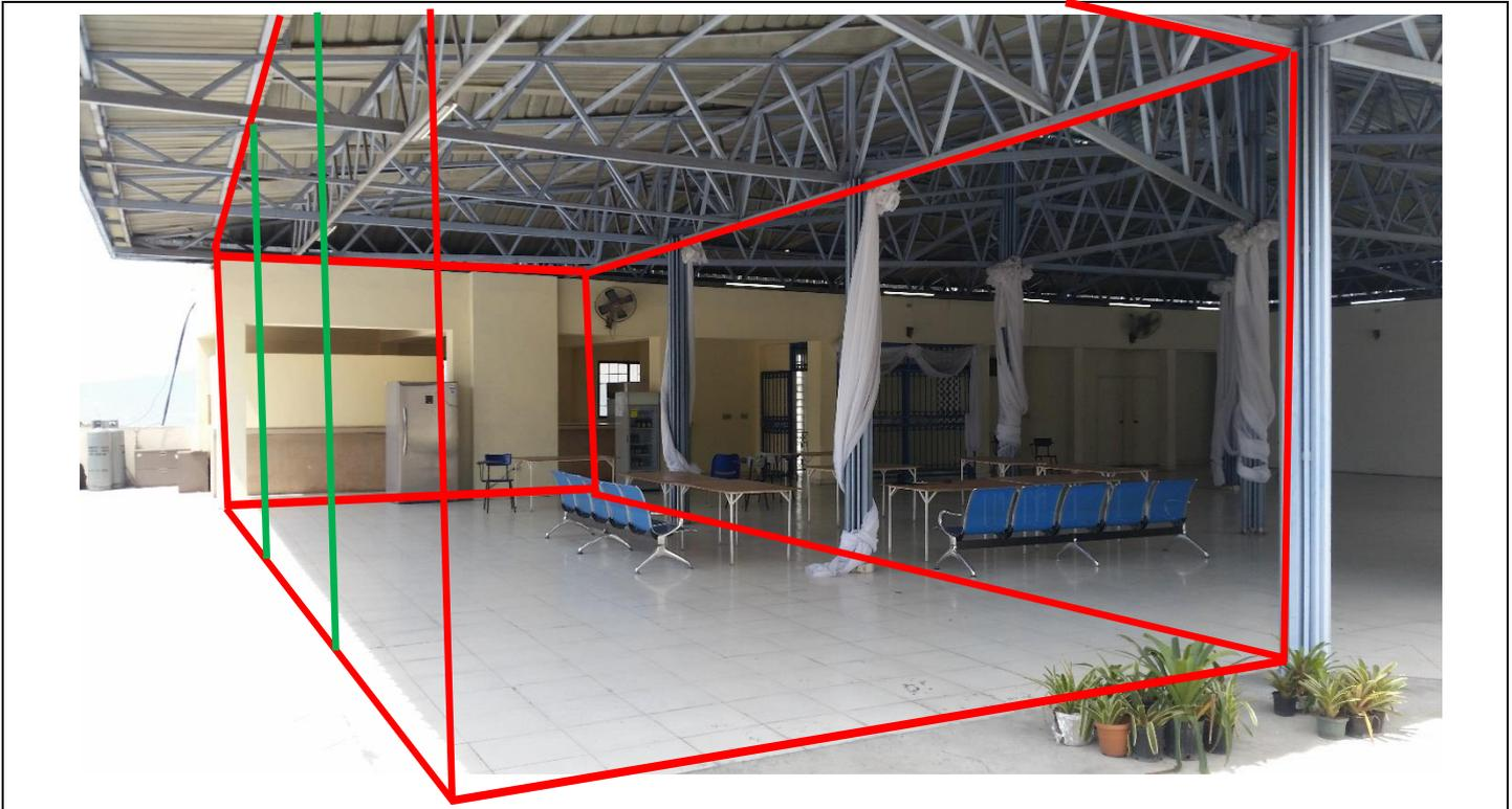
Représentation schématique de l'espace du centre (en vert les tubes de 350x350mm alignée aux poteaux circulaires existants, en rouge le profil des murs)
