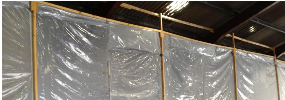
Figura 5: Traslapes de las láminas de plástico
