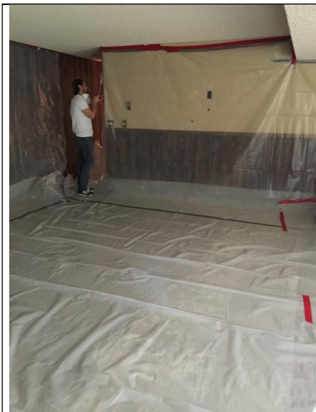
Figura 4: Pared temporal de plywood y plástico
