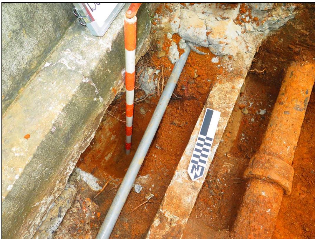
Detalle del final de la excavación. Se rompió la pared oriental de la segunda canal para poder acceder hasta el fondo del cimiento de la pared norte de la Gobernación, donde está la punta de la escala en la imagen al fondo.
