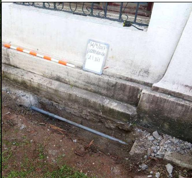
Remoción de la primera capa de bloques de la canalización actual, y exposición de la tubería de PVC para cables eléctricos dentro de la misma.
