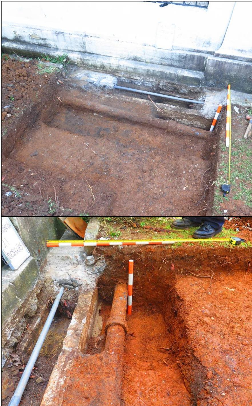
Avance de la excavación. Se removió la primera canal, se expuso el fondo de la canal anterior y la tubería de hierro que discurre por fuera de estas.
