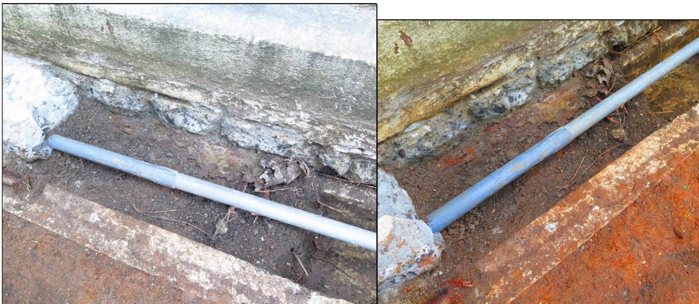
Detalle de la excavación después de la remoción de la primera canal. Se observa el tubo de PVC inmerso en el concreto que conforma el fondo de la canal y bajo este, los restos de la lámina de zinc y el relleno (nivel 5) dentro de la canal inferior y más antigua.
