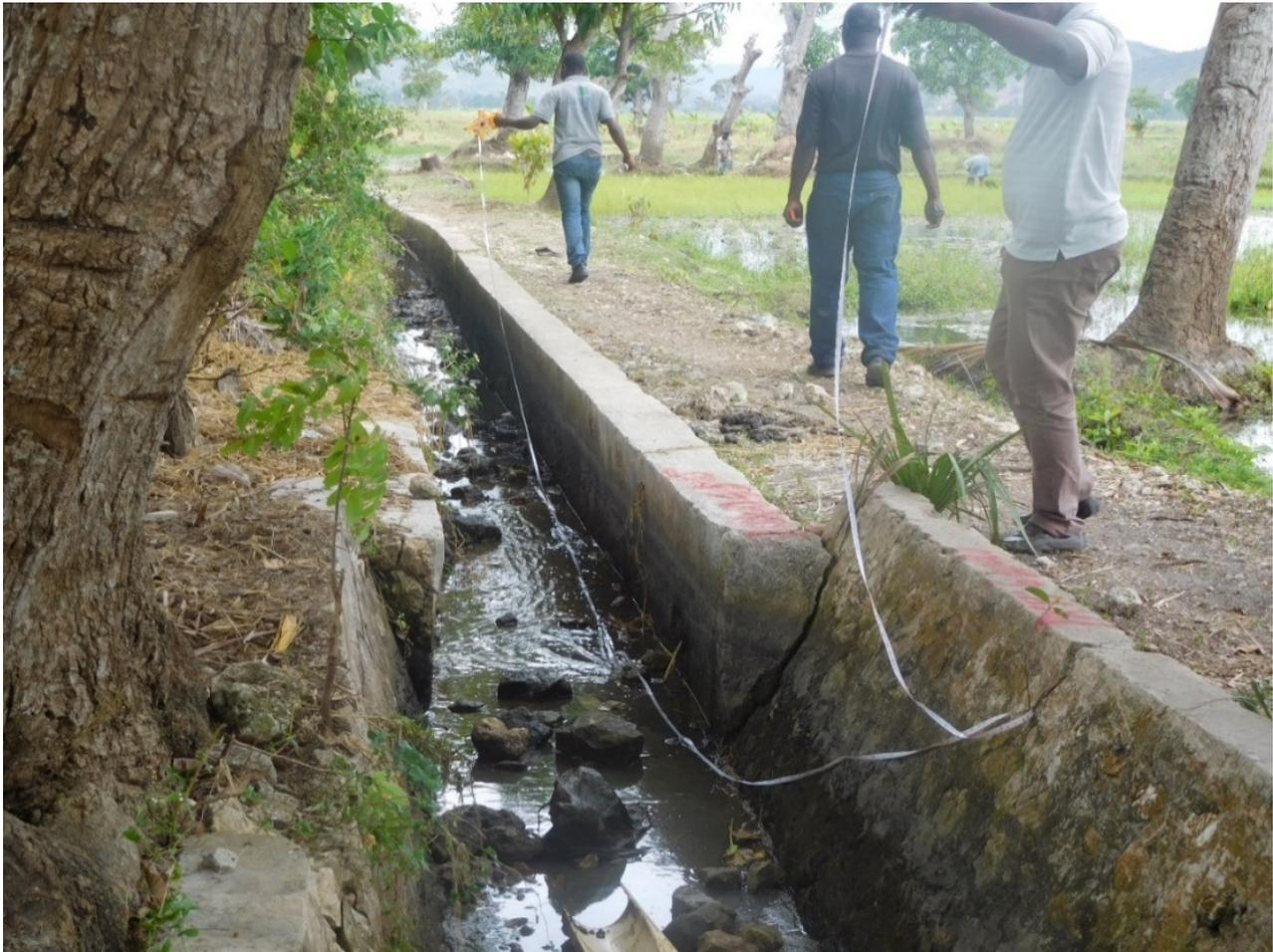
*Figure 8 : Vue d'un tronçon du canal tête morte sédimenté*
