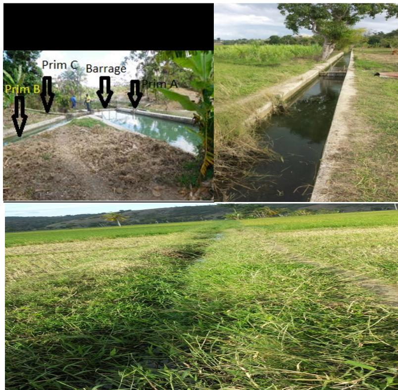
Figure 33: Vue ponctuelle du canal primaire B; de la partie maçonnée et celle en terre battue
