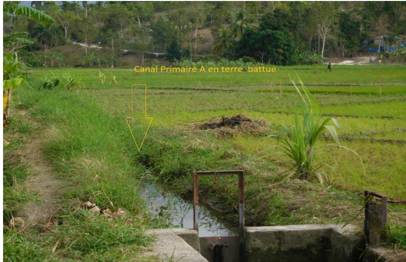
Figure 32 : Vue ponctuelle de la partie en terre du canal primaire A enherbé et sédimentée
