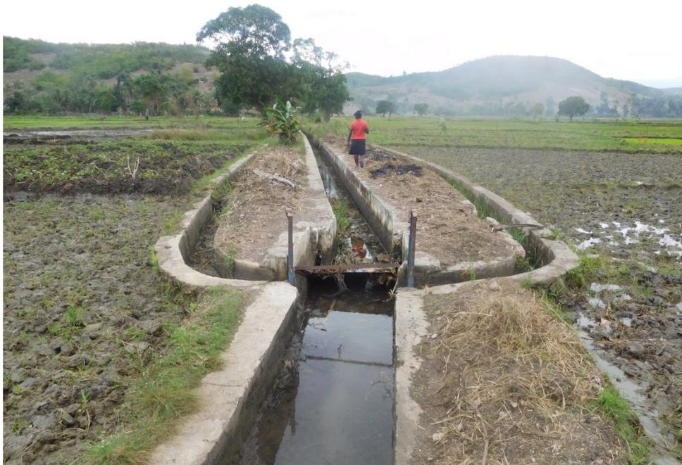
Figure 15 ; Vue ponctuelle des canaux secondaires 1 et 2 rattachés au primaire 1
