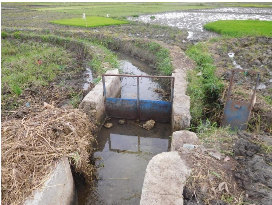
*Figure 13 : Vue de la partie finale maçonnée du canal primaire 2*
