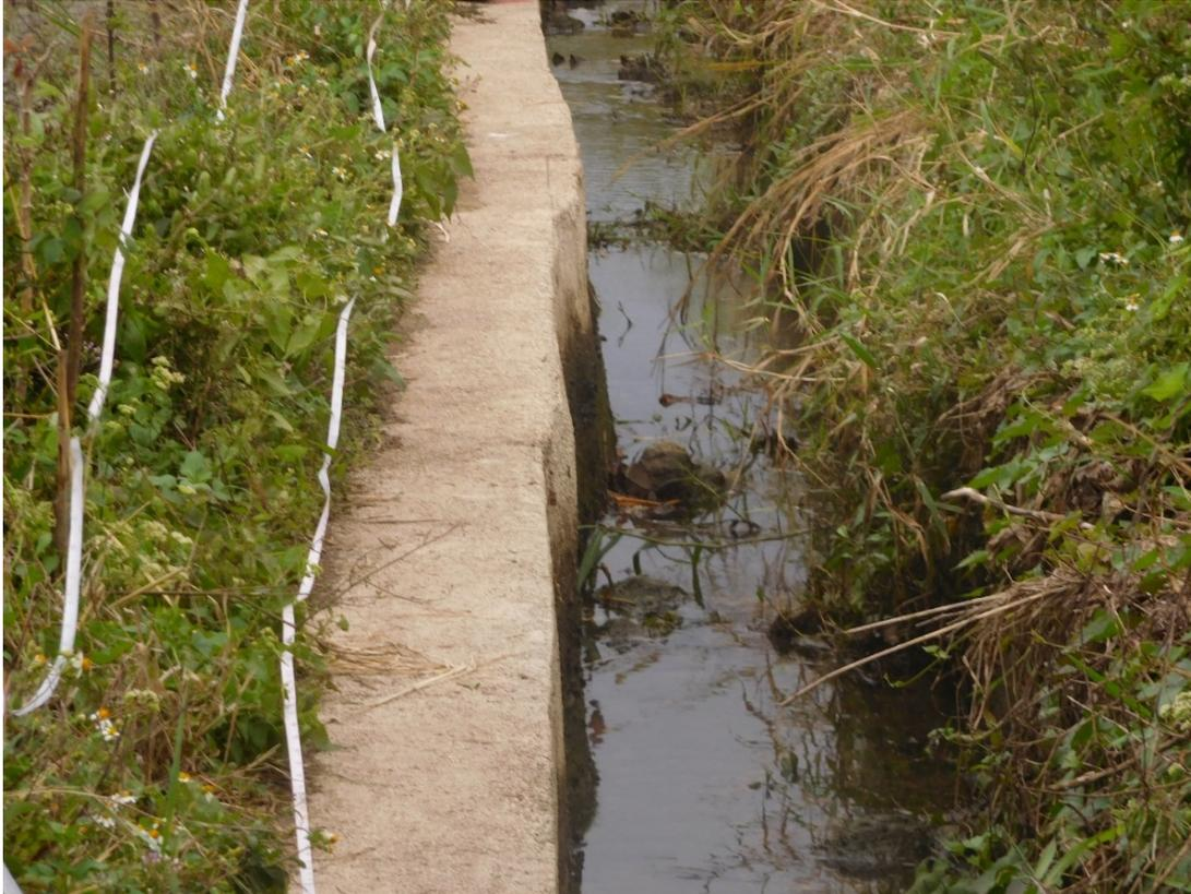
*Figure 14 : Vue ponctuelle du canal primaire 2 enherbé et sédimenté*
