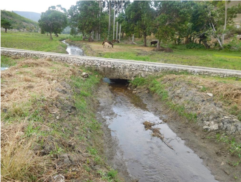
Figure 23 : Vue d'un drain collecteur en dessous du canal tête morte.
