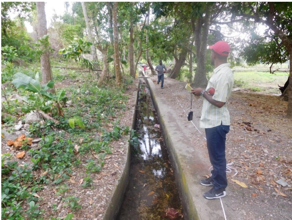
*Figure 10 : Vue du problème de contrepente au niveau du Canal tête morte*
