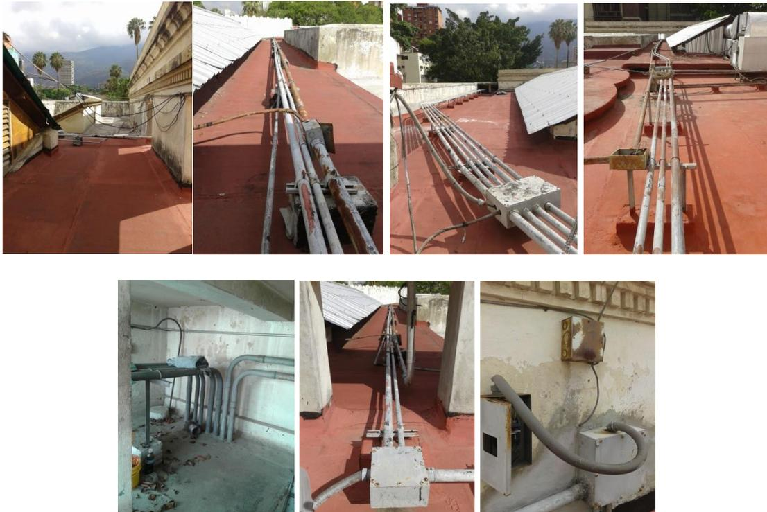
Una vez instaladas las cámaras en el interior de las salas superiores del edificio moderno, los cableados deberán bajarse por el espacio vacío al lado de la rampa. Ya existen allí unas
