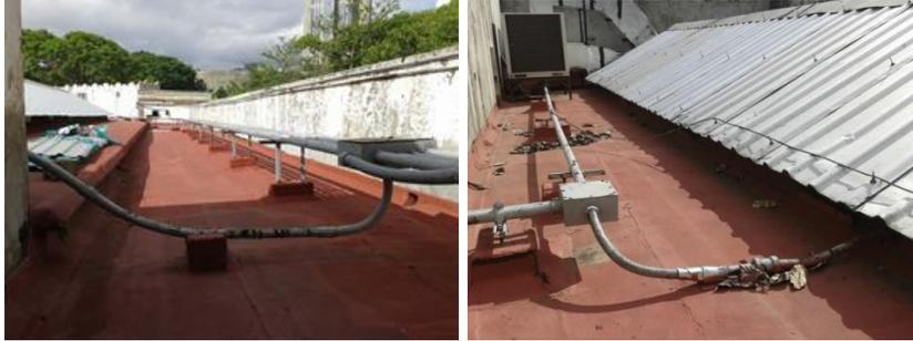
Ambos edificios representan, dada su naturaleza distinta, un reto para la instalación de nuevas tecnologías. Por una parte, el edificio neoclásico tiene lucernarios en las salas que permiten llevar las instalaciones al techo y desde allí recorrer la distancia al cuarto de seguridad por el nivel azotea utilizando tubería para exteriores.
