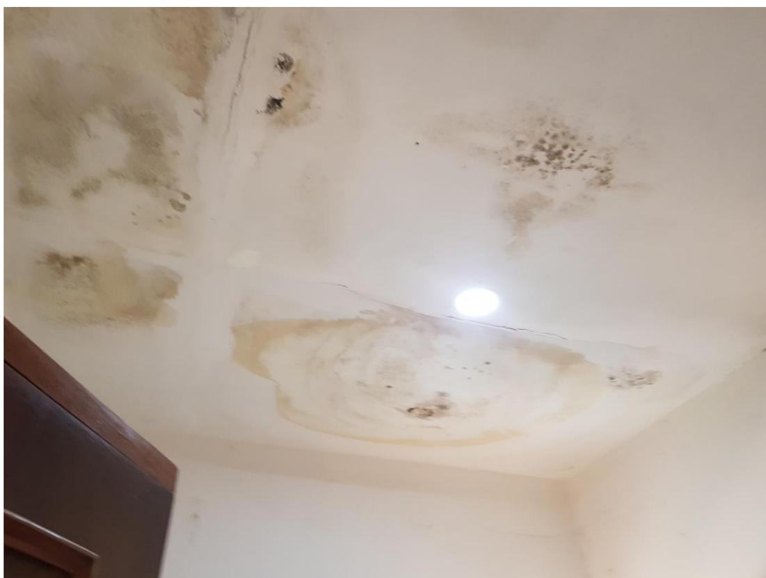
Nesta fotografias acima podemos constatar os tectos falso completamente desfeita ou com manchas provocadas pela infiltração das aguas das chuvas na cobertura
