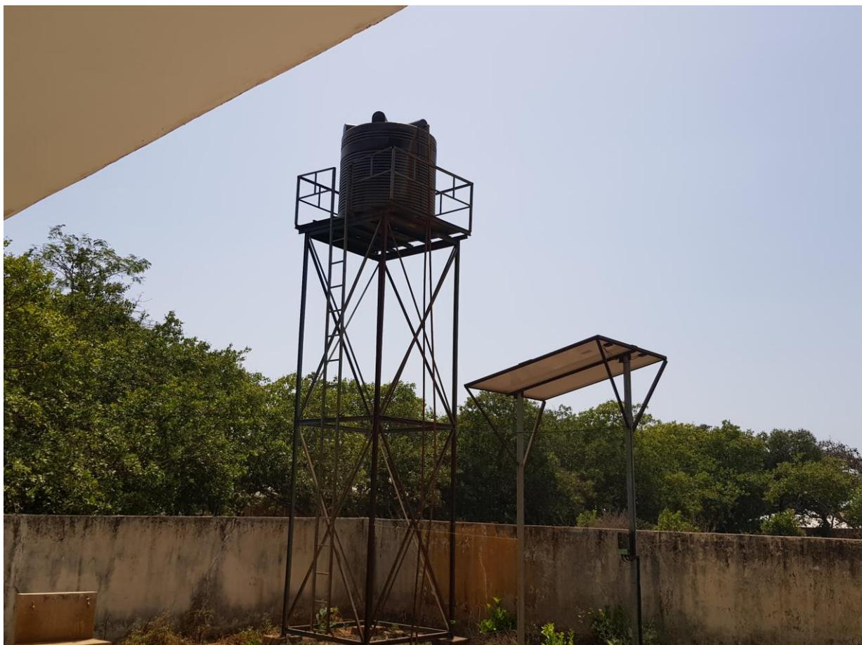
Nesta fotografia podemos constatar que as estruturas que suportam os painéis solares ficam debaixo do depósito o que provoca asombreamento e impedimentos de funcionamentos deste para bombagem de agua durante todo o dia, para require a sua trasladação para outro local completamente exposta ao sol.
