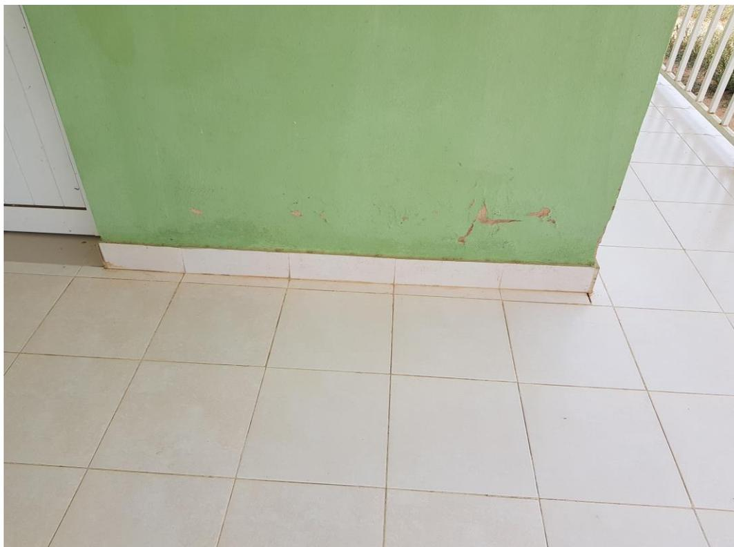
Nesta fotografia podemos constatar a humidade nas paredes quais suscitam a demolição e refeição das mesmas.
