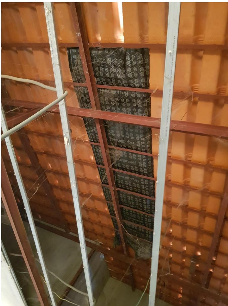
Nesta fotografia podemos ver a tentativa de estancar a penetração das águas pluvias no telhado através da utilização de telas asfálticas, quais não sortirão efeitos.
