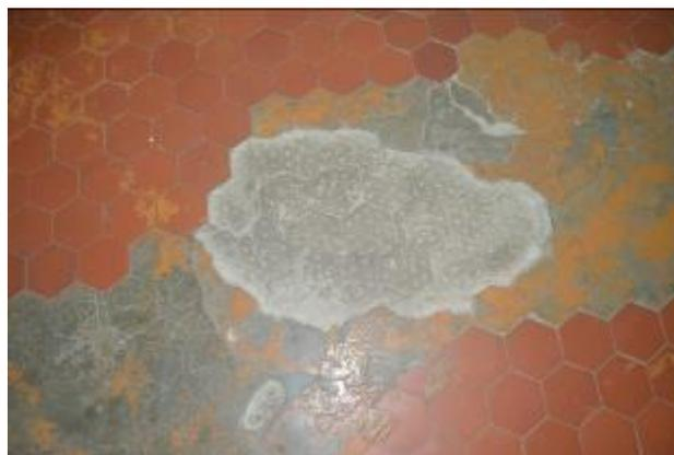
*Фото 8. Состояние пола из керамических плиток помещения «2»*
