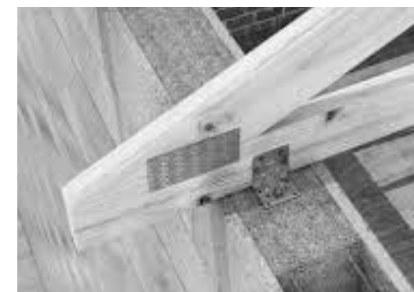
ANCORAGEM DE ASNA / TRUSSES ANCHOR
