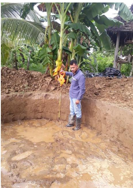
Figura No.1 Excavación para tanque de 20 m<sup>3</sup>
