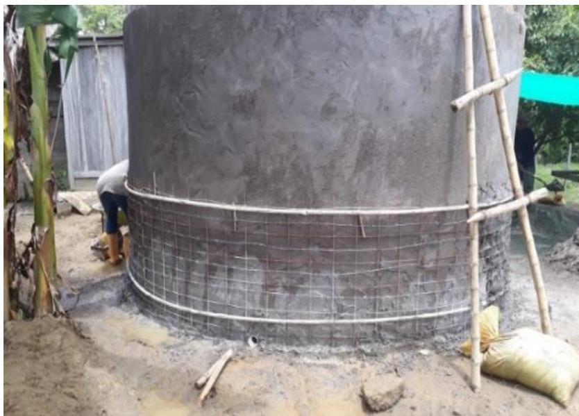
Figura No.11 Instalación del refuerzo para el anillo perimetral
