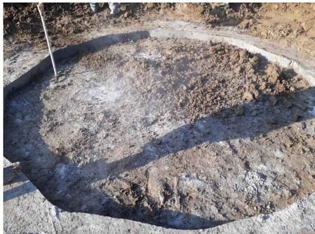
Figura No.4 Viga perimetral de cimentación
