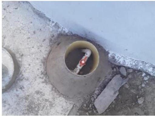
Figura No.16 Llave de paso entre bomba manual y tanque
