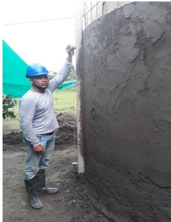
Figura No.10 Aplicación del mortero por capas
