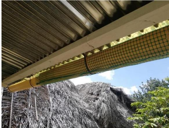
Figura No.20 Canaleta de configuración lateral sujeta a vigas y protegida con malla sintética
