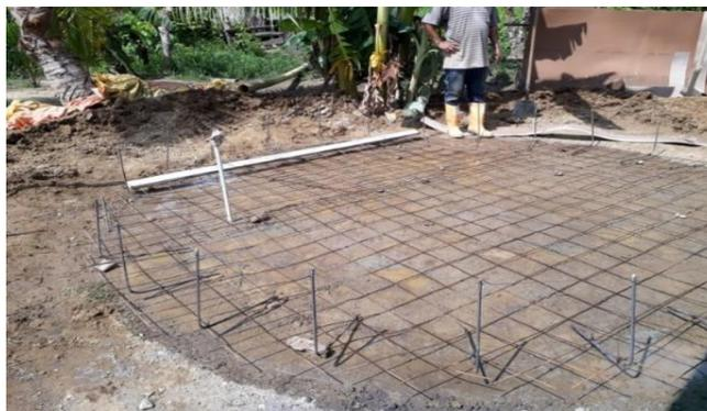
Figura No.1 Disposición acero de refuerzo
