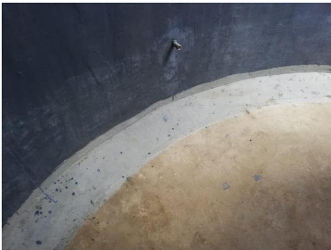
Figura No.13 Aplicación de resane a media caña con mezcla de mortero impermeabilizado
