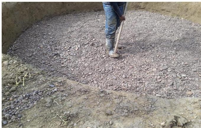
Figura No.2 Relleno con material de canto rodado
