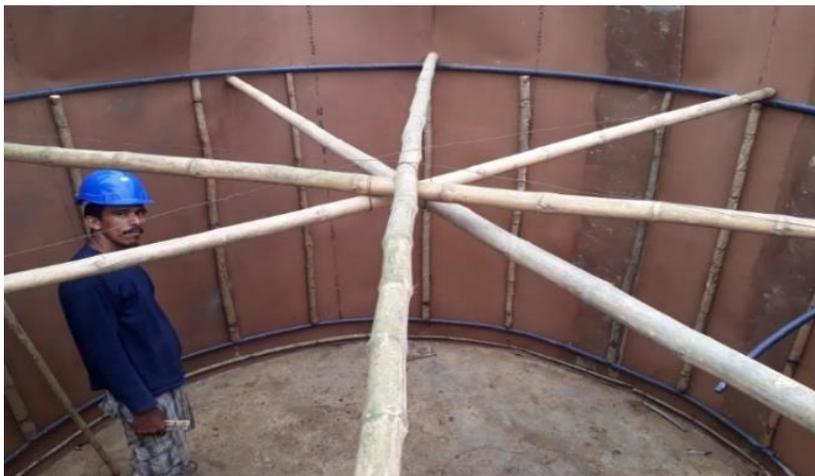
Figura No.8 Disposición de la formaleta y soportes internos
