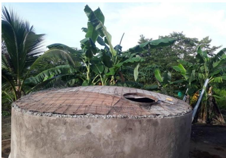
Figura No.14 Instalación de refuerzo en cubierta
