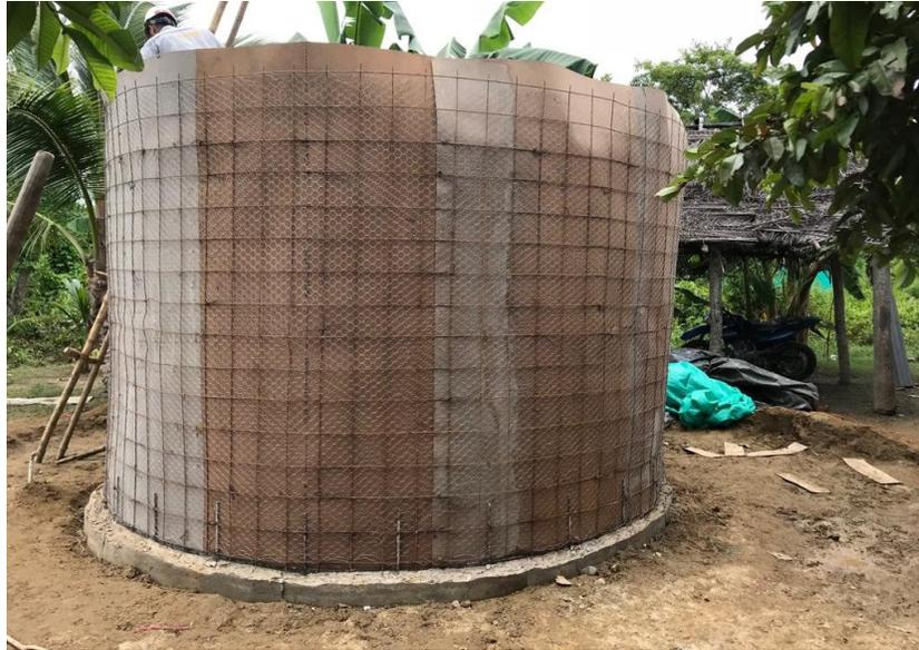
Figura No.9 Disposición acero de refuerzo y las mallas de gallinero
