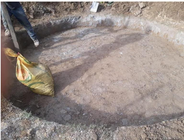
Figura No.3 Mejoramiento de relleno con suelo-cemento
