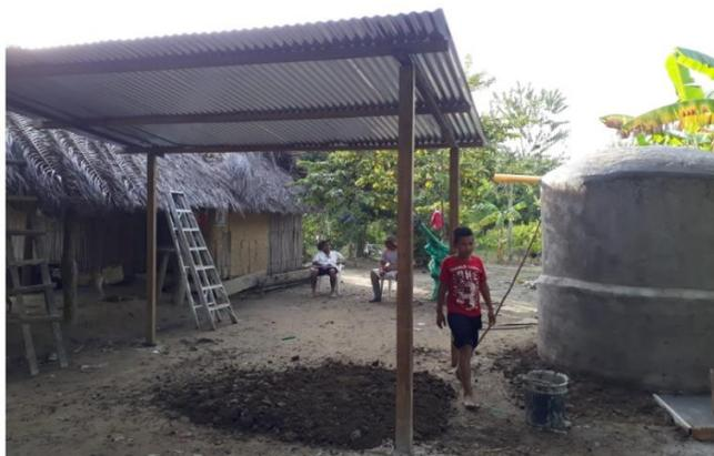
Figura No.19 Pérgola en madera y zinc en proceso de construcción
