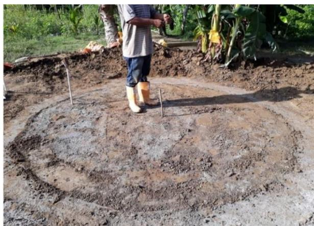
Figura No.5 Relleno área fuera de la viga hasta nivel de terreno
