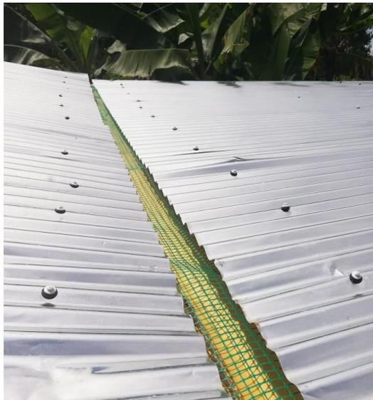
Figura No.21 Canaleta de recolección de configuración central protegida con malla sintética
