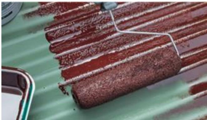
Figura No.22 Protección de tejas de zinc con pintura anticorrosiva
