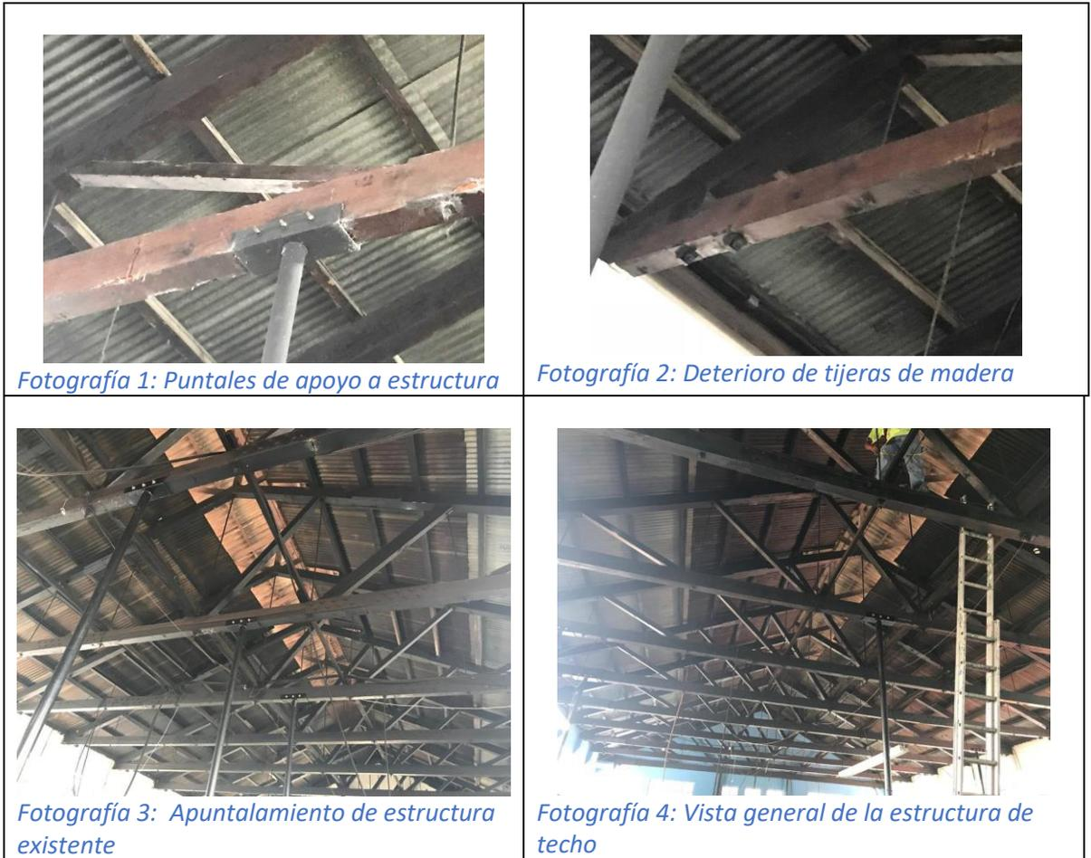
La estructura de soporte del techo se conforma por 19 tijeras de madera separadas a 178 ½" (4.534 m) y con un ancho total de 46.25 pies (14.097 m). De las 19 tijeras existentes, 15 forman el monitor de ventilación y se denominan tipo M y 4 son a dos aguas y se ubican en ambos extremos del techo y se denominan tipo A.
