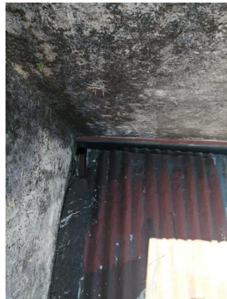
**RESPUESTA 4:** Los muros deteriorados deberán repararse adecuada y posteriormente impermeabilizar. Los costos de estos trabajos deberán cargarse al renglón 502 Canal pluvial con lámina galvanizada C-24.
