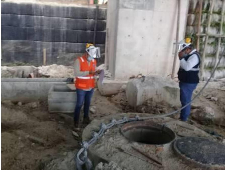
PT-02, ejecución de canaletas de drenaje, y empalme a buzón existente.
