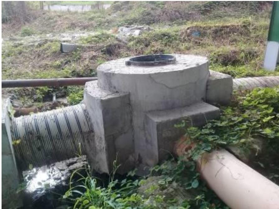
PT-01, se debe reconformar subrasante, reacomodar y aplomar buzón existente, afectado por erosión.
