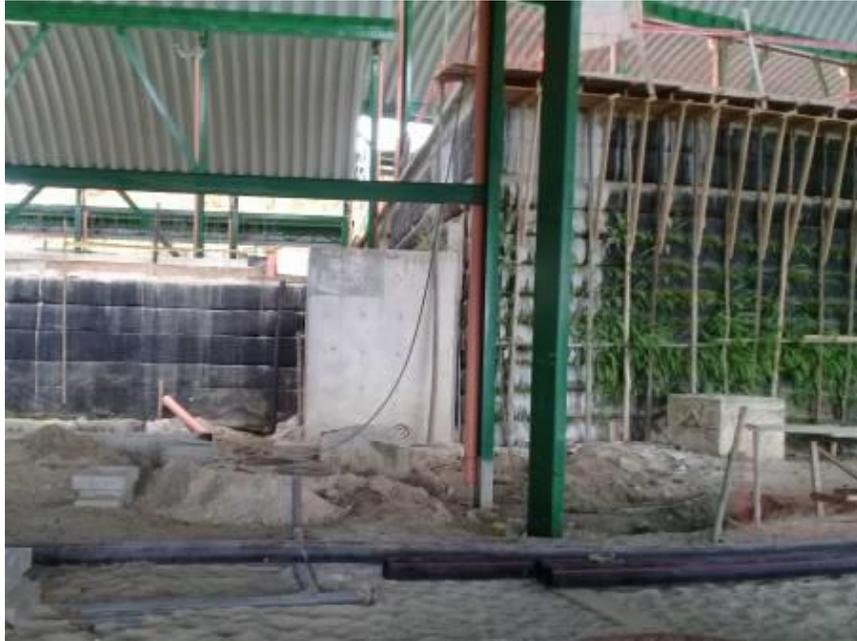
Zona RAMPA TRAPEZOIDAL, se ha proyectado completar las bajadas pluviales y ejecutar la red de Ø6".
