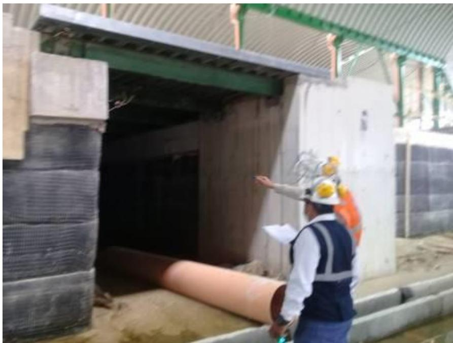
PT-03, ejecución de canaletas de drenaje, en zona de túnel.
