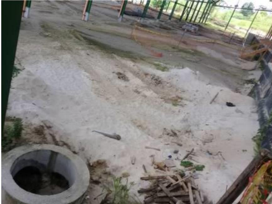
PT-01, entre Ejes 05/ 10, se contempla ejecutar red de  $\varnothing 600$  y  $\varnothing 400$  mm; también, un canal de concreto de 0.40m de ancho; asimismo, 03 buzones para drenaje pluvial.
