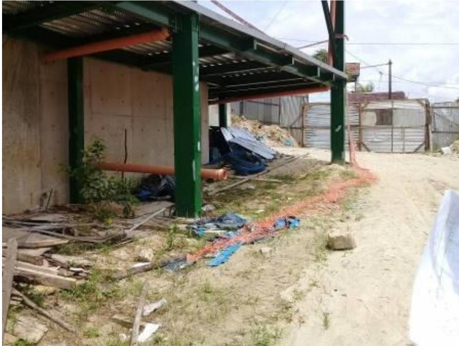
PT-05, eje 06, se instalará una red provisional  $\text{Ø}250$  mm, a través de un tubo de  $\text{Ø}6''$ .
