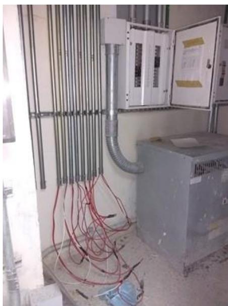
Foto 13. Tablero 3 y transformador de 75 kVA, cuarto eléctrico 3
