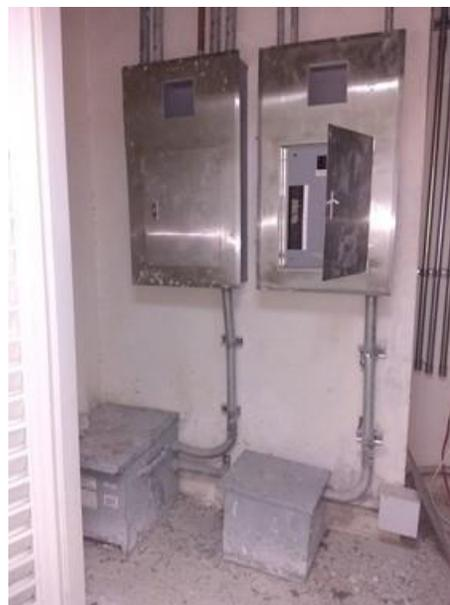
Foto 12. Tableros 1 y 2 y transformadores de 15 y 5 KV
