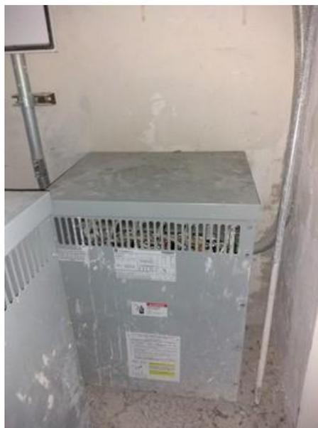
Foto 16. Transformador de 30 Kva
