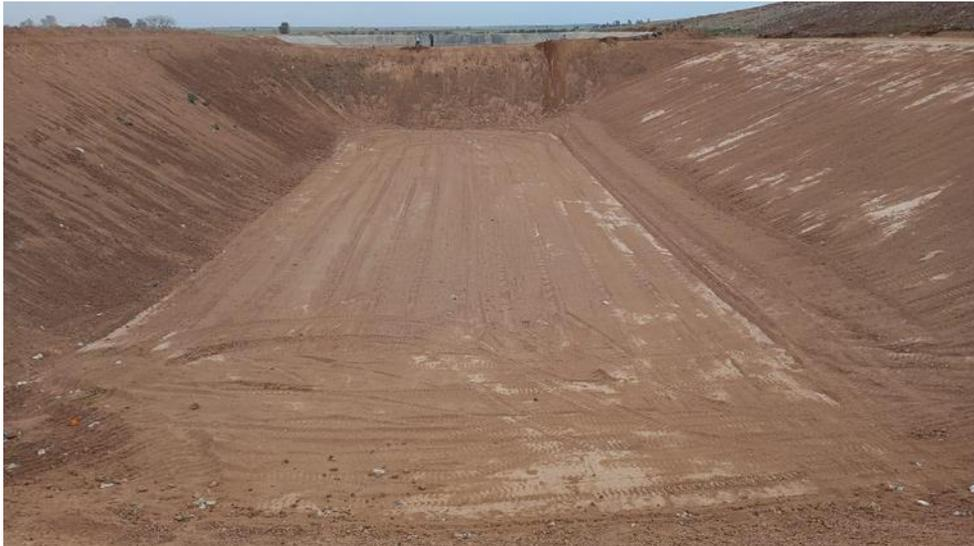
Foto N°1: Celda G. Finalizada para el proceso de impermeabilización.
