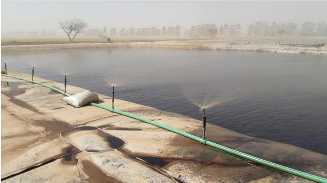
Foto N°3: Sistema de evaporación forzada de lixiviado con pulverización.
