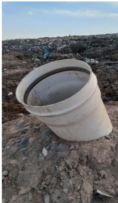
Foto N°4: Tubo de Extracción de Lixiviado de PVC.
