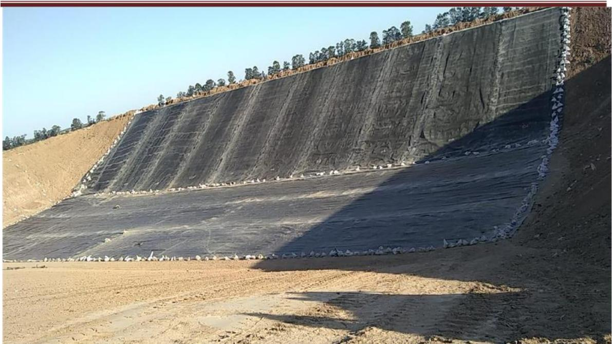
Foto N°2: Celda G en proceso de impermeabilización.
