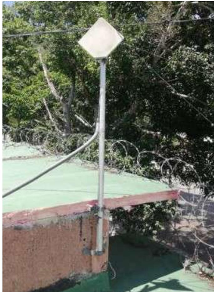
Imagen Referencial tipo de instalación mástil en pared con abrazaderas.
