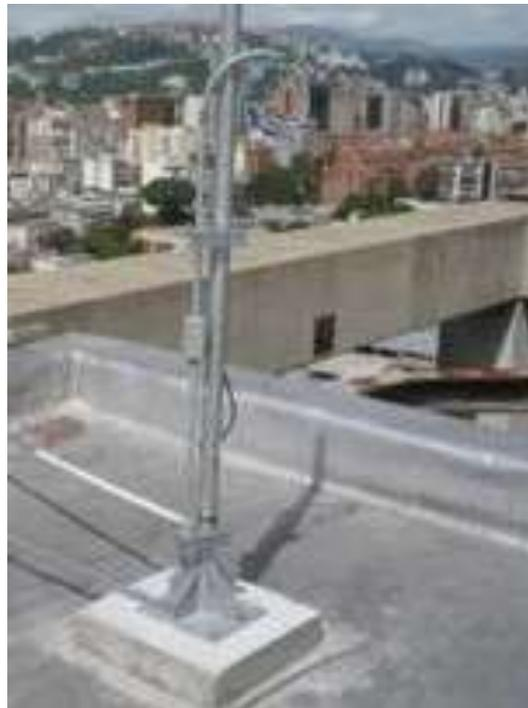
Imagen Referencial tipo de instalación mástil de pedestal.
