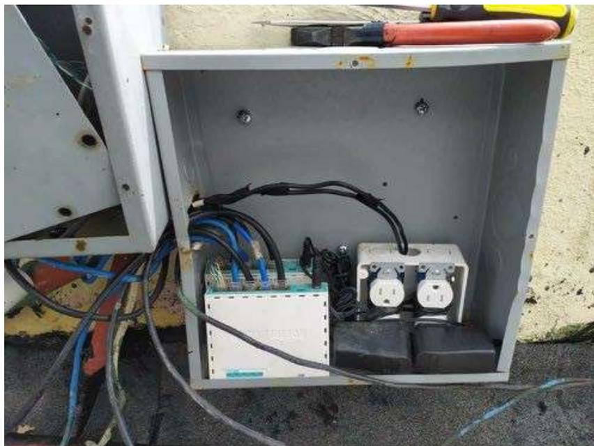
**Imagen Referencial.** El Switch Poe se ubicara dentro de caja metálica cerrada para evitar que la manipulen.
