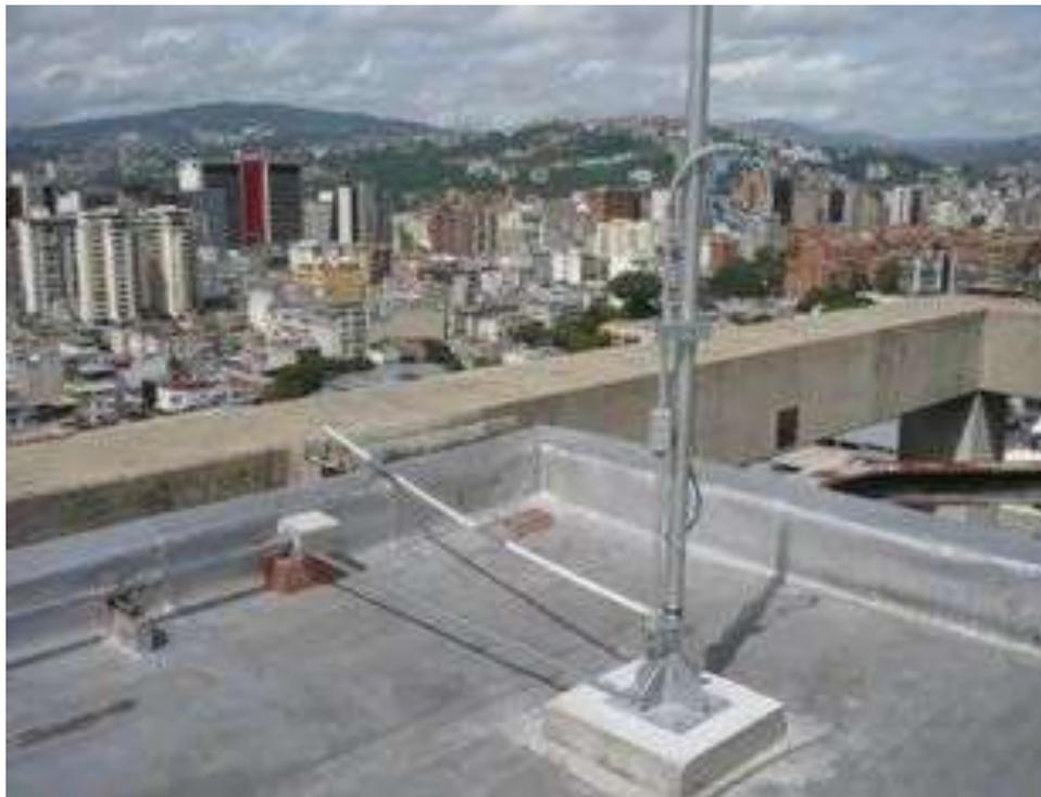
Imagen Referencial 3 mts base de concreto y 3 mts de mástil
