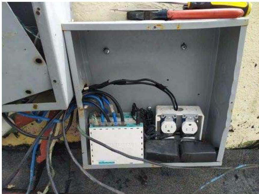
**Imagen Referencial.** El Switch Poe se ubicara dentro del Auditorio caja metálica cerrada para evitar que la manipulen.
