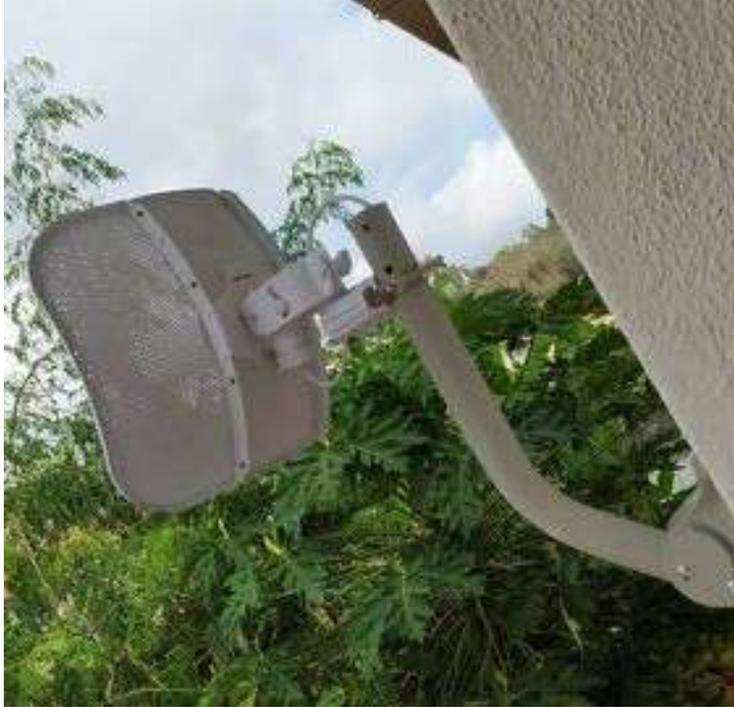
Imagen Referencial tipo de instalación base con brazo de pared para AP.
