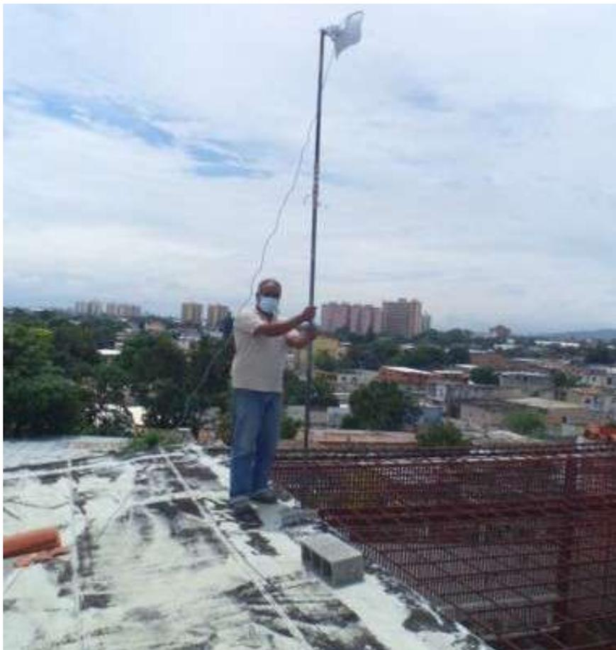
Platabanda de la Casa Parroquial, ubicación recomendada para la instalación de la antena con un mástil tipo pedestal de 5 mts y vientos. En el mismo mástil se instalara AP wifi para hacer repetición mesh hacia el colegio.
