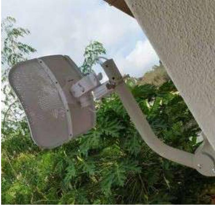
Imagen Referencial tipo de instalación base con brazo de pared.
