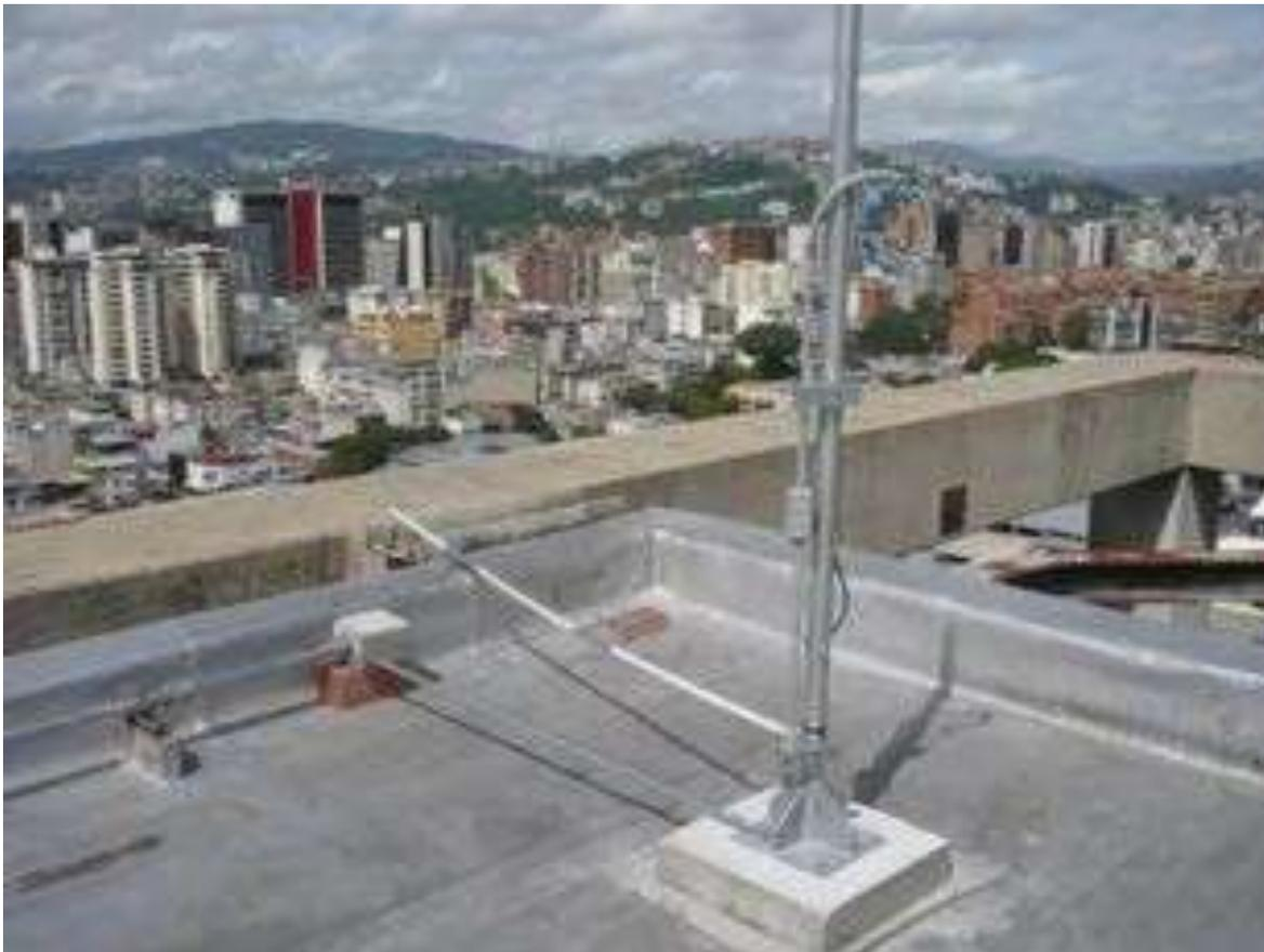
Imagen Referencial tipo de canalización con tubería EMT que debe realizarse por el suelo. Importante destacar la terminación donde va la antena con tubería flexible mirando hacia el suelo para prevenir la entrada de agua. .
