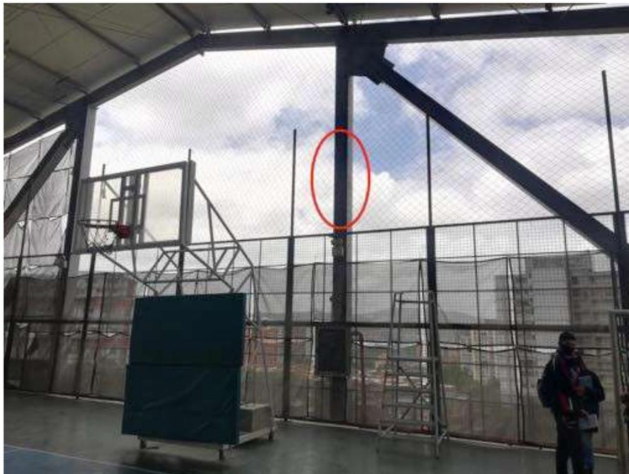
Se debe realizar instalación de un brazo para antena soldado a la viga del círculo en Rojo.
