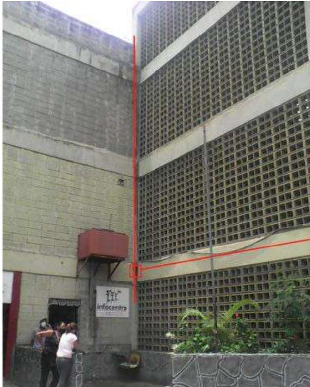
Líneas Rojas Recorrido canalización tubería EMT desde antena hacia Infocentro. Recuadro rojo es una caja de paso para derivación del cableado UTP hacia AP Wifi.
