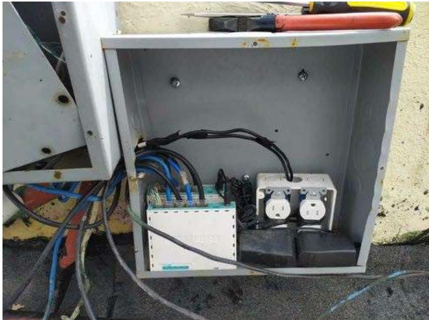
Imagen Referencial. El Switch Poe se ubicara dentro de la oficina de la directora en una caja metálica cerrada para evitar que la manipulen.
