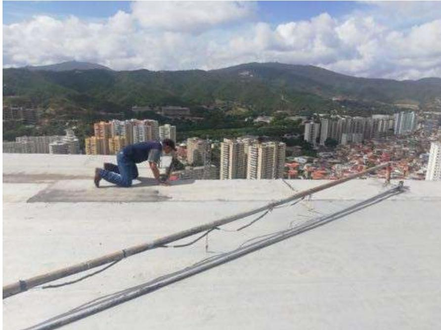
Se debe colocar tubería EMT hacia pisos inferiores con bases para no perforar manto asfáltico.
