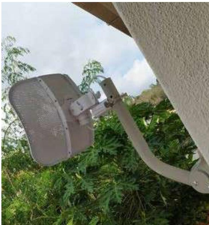
Imagen Referencial tipo de instalación mástil de pedestal.
