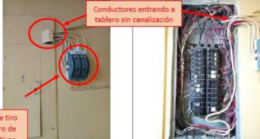
Conductores entrando a tablero sin canalización
