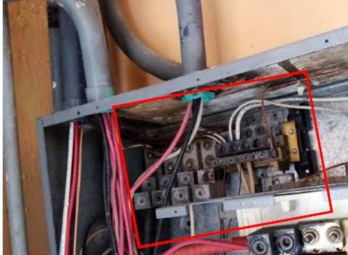
Imagen 25. Muestra única barra de neutro en tablero MDP-600, a la cual se conectan también conductores desnudos (conductores de puesta a tierra) de las cargas ramales asociadas a este tablero. **Esta condición no es permitida después del dispositivo de desconexión principal según el artículo 250 del RIE.**
