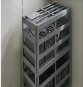
Figura 10. Armário das baterias.
